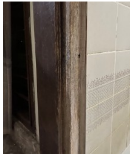
Lapisan finishing terkelupas meluas
