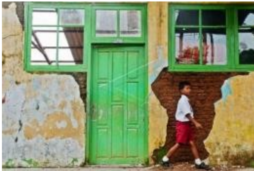
Lapisan finishing terkelupas meluas
