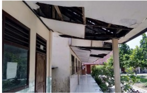
Penutup langit-langit melendut sangat besar dengan kemungkinan keruntuhan besar
