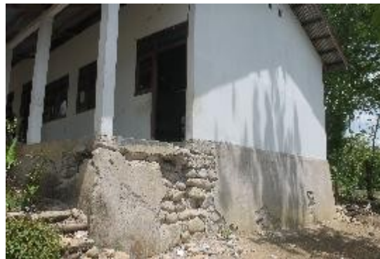
Pondasi patah
