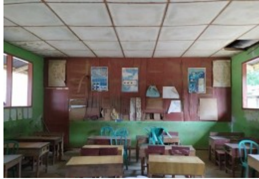
Lapisan finishing lepas sebagian
