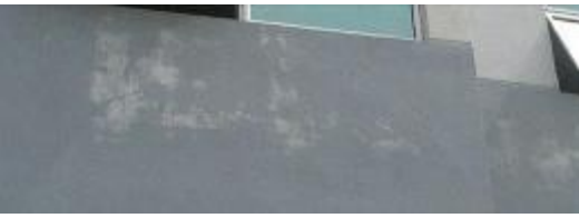
Perubahan warna cat pada sebagian
