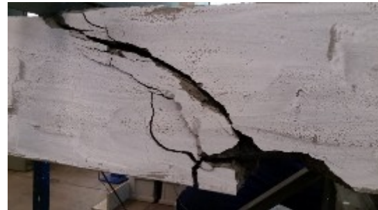
*Balok patah/ runtuh Plat dan balok lain yang menumpu pada balok tersebut ikut rusak
