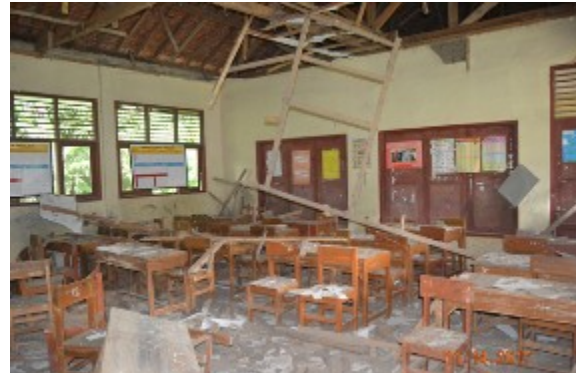
Rangka langit-langit runtuh
