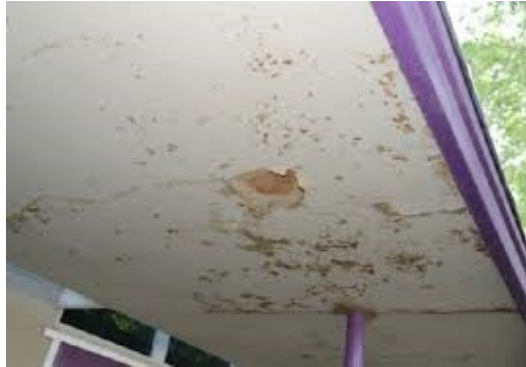
Lapisan finishing terkelupas meluas
