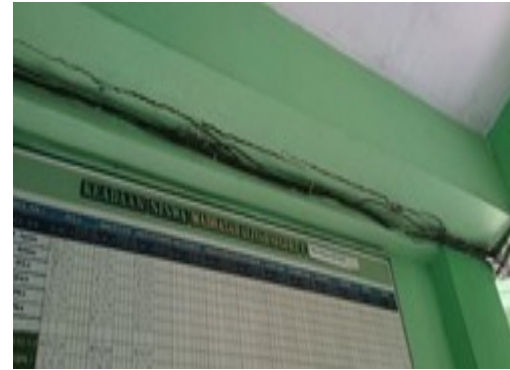
*Balok melendut, lebar retak > 1.0 mm Retak meluas pada beberapa tempat
